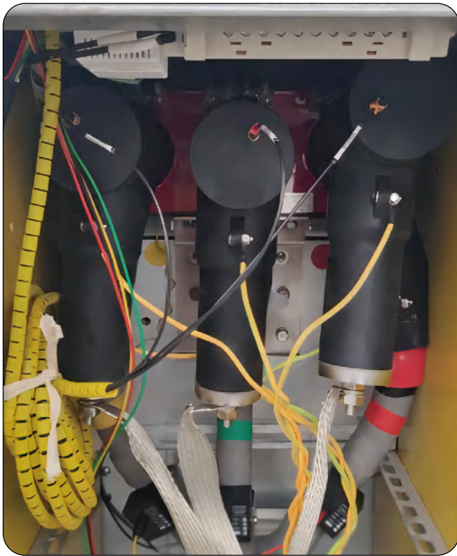
环网柜光纤测温安装示意图
